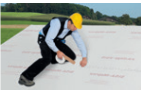
Instalación de barreras de vapor para aislamiento sobre cabrios
