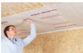
Instalación de barreras de vapor
