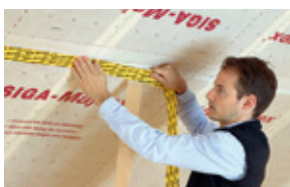
Solapamiento de barreras de vapor
